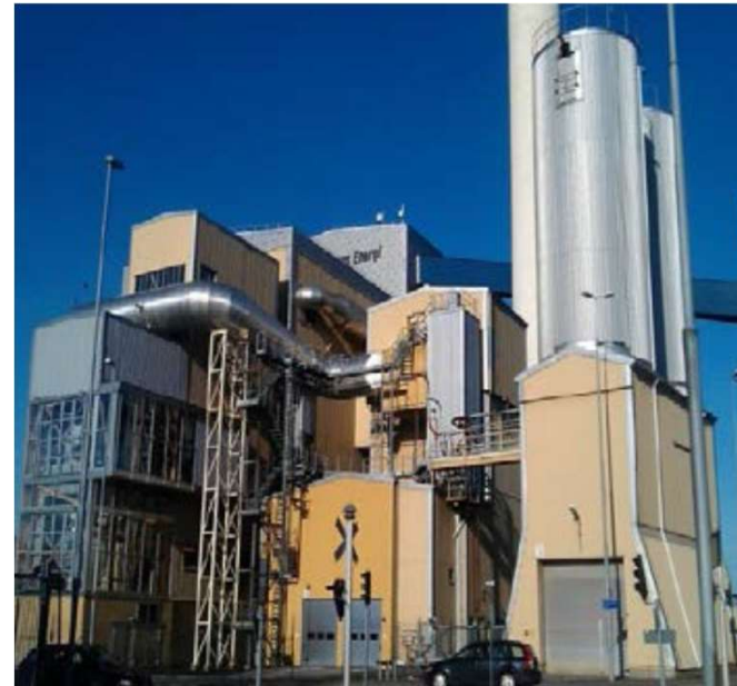
Göteborg Energi 130MW (BFB)
