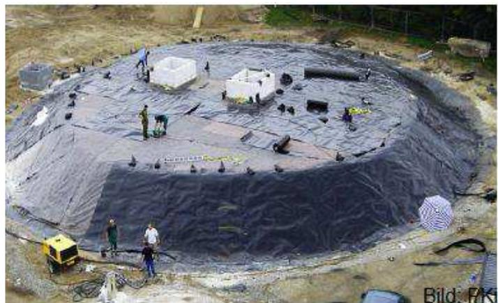
Abbildung 2 Glasschaumschotter, Wärmespeicher in Eggenstein-Leopoldshafen, Quelle: ITW
