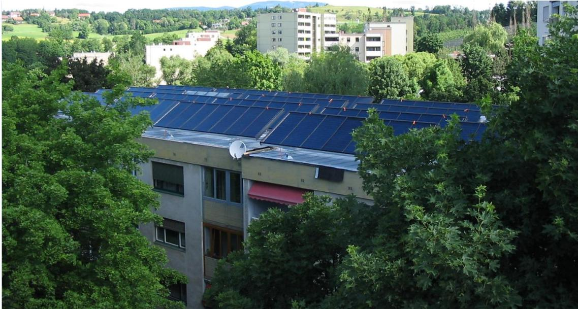
Abbildung 26 Kollektoren am Dach eines Wohngebäudes Berliner Ring (Quelle: SOLID)
