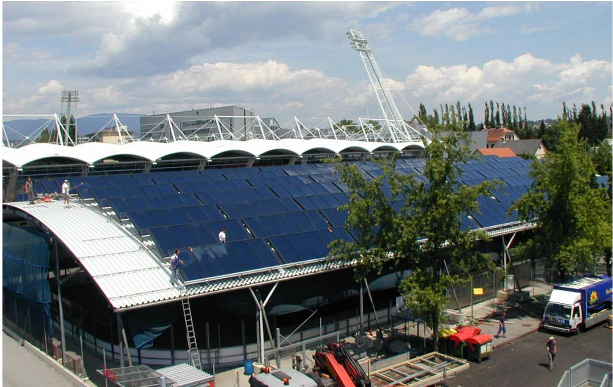
Abbildung 23 Montage der Kollektoren am Stadion Liebenau (Quelle: SOLID)
