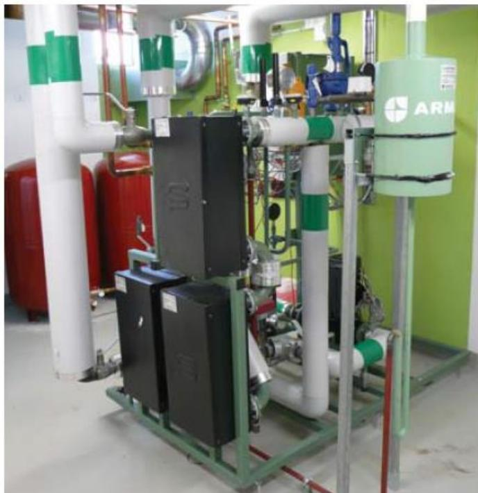
Abbildung 29 Einspeisestation der Firma Armatec (Quelle: Solites 2015)
