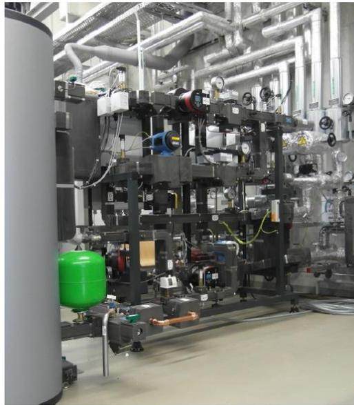
**Abbildung 32 Pilotstation der kombinierten Hausanschluss und Netzeinspeisestation im Zentrum für Energietechnik TU Dresden (Quelle: Rühling 2016)**
