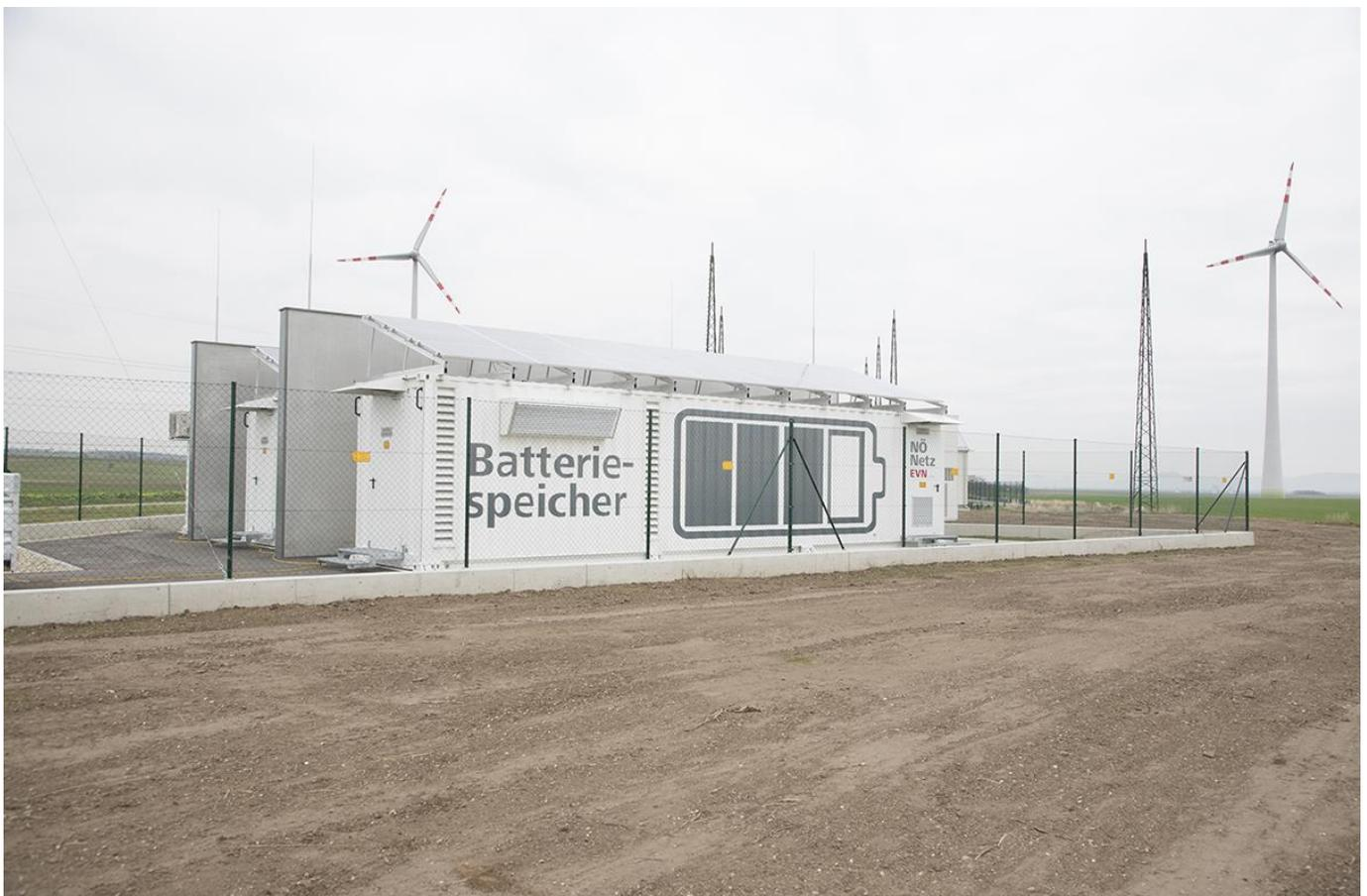
Abbildung 3: Betriebsbereite Demonstrationsanlage © NNÖ
