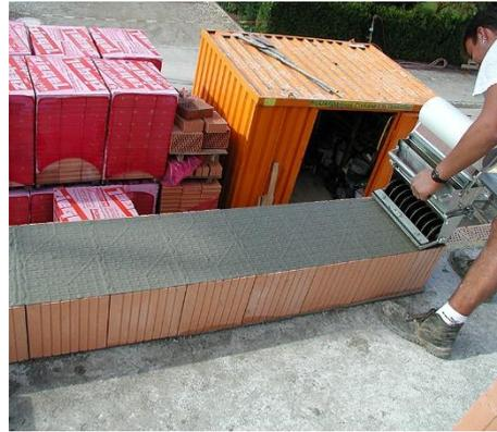
(b) Durchgehende Mörtelschicht durch das eingelegte Gewebe
