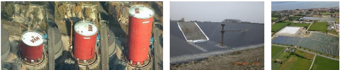
Abbildung 1: (links) Wärmespeicher des Fernwärmenetzes in Linz (Quelle: [www.vam.at](http://www.vam.at)); (mitte/rechts) Erdbecken-Wärmespeicher in Marstal (sunstore IV), (Quelle: Marstal Fjernvarme)
