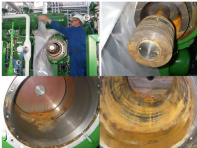
Abbildung 30: Rostbildung in einem Kolbenverdichter
