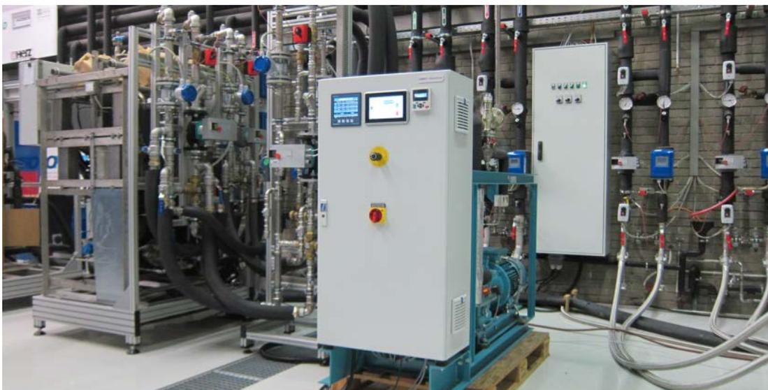
**Abbildung 2.11:** Im Labor des Arbeitsbereichs Energieeffizientes Bauen der Universität Innsbruck eingebauten Funktionsmuster der AKM (links) und KKM (rechts)
