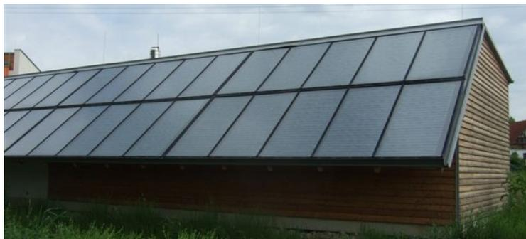
Abbildung 2: Dachintegration von Solarkollektoren mit 2 Reihen übereinander
