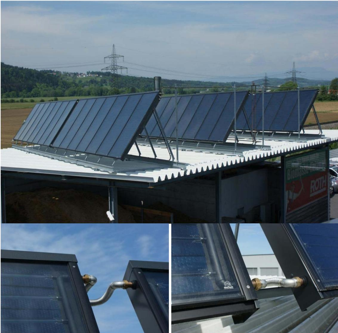
Abbildung 47: Installierte 100 m<sup>2</sup> Feldanlage bei Fa. Roth mit Schaltungsdetails im Bereich der Kollektorverbindungen.
