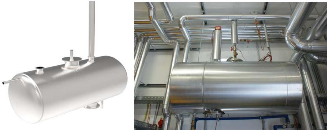
*Abbildung 46: 3D-Darstellung der Konstruktion des Entleerbehälters (links) für die Feldanlage mit Anschlüssen für den Solarkreis (oben zentral, unten rechts, der Messtechnik (oben und unten rechts) und eine Möglichkeit zur Erweiterung des Ausdehnungsvolumens (Flansch oben links). Einbausituation des gedämmten Behälters (rechts).*
