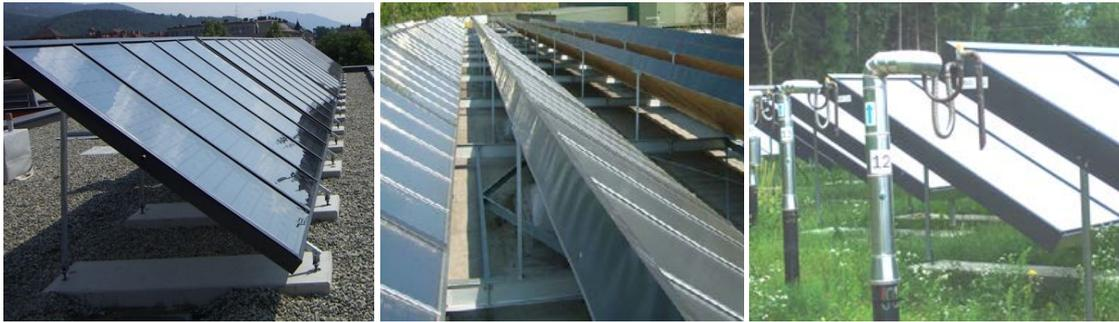
Abbildung 3: Ausführungsformen von frei aufgeständerten Kollektoren (Links: auf Flachdach mit Betonfundament, Mitte: auf Flachdach mit Stahlunterkonstruktion für Befestigung der Aufständerung, Rechts: im Freien aufgeständerte Kollektoren mit Betonfundament)
