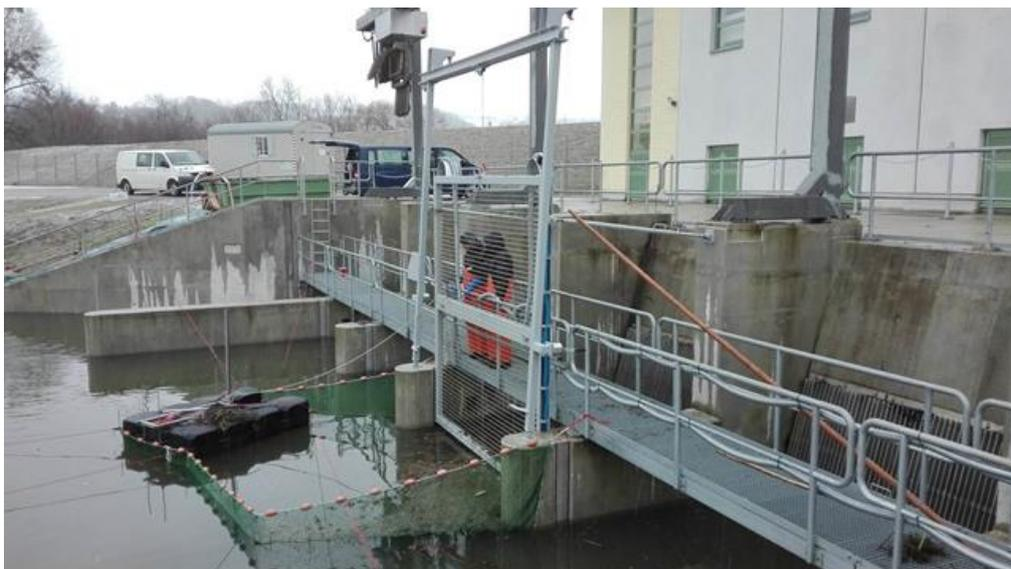
Abbildung 10: Elektro-Seilrechen am Pumpwerk Saubach/Deggendorf, bestehend aus zwei Feldern und Schwimmponton an dem das Multibeam-Sonar ARIS befestigt wurde
