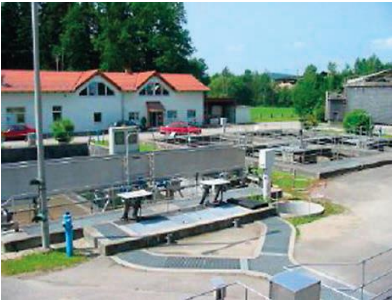
Abbildung 21: Kläranlage in Freistadt, Quelle RHV Freistadt u.U.
