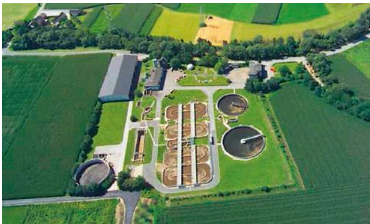
Abbildung 22: Kläranlage in Gleisdorf, Quelle AWW Gleisdorfer Becken
