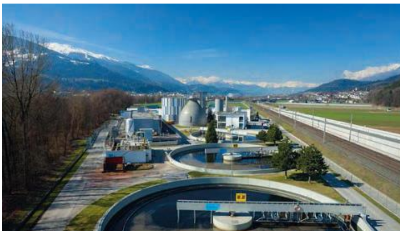
Abbildung 23: Kläranlage des AWV Hall-Fritzens, Quelle: AWV Hall-Fritzens
