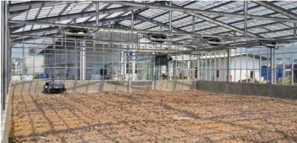
Abbildung 6: Speichertrockner als Beispiel für eine solare Trocknungsanlage; Quelle: Thermo System
