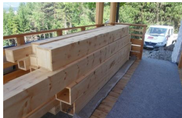
Abbildung 48: Zirbenholzkanäle nach Anlieferung vor Montage
