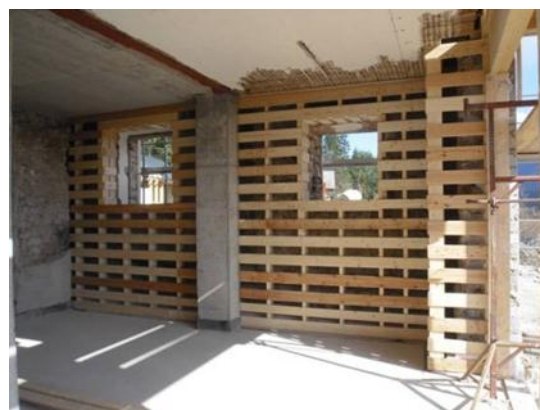
Abbildung 19: Holzgerippe samt Streuschalung
