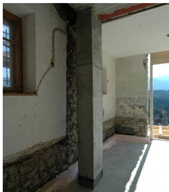
Abbildung 17: neue Decke und Stütze 30 cm vor der Außenwand
