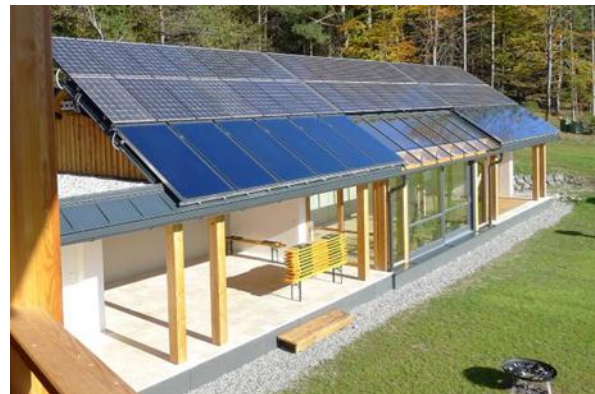
Abbildung 71: Glashaus vom Laubengang des Bestandsgebäudes aus fotografiert.
