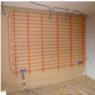
Abbildung 42: Wandheizung vor Aufbringen des Lehmputzes
