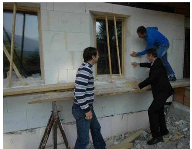
Abbildung 9: Die Außendämmung im nördlichen Bereich des Erdgeschoßes wurde in Form von 26 cm starken Mineralschaumplatten aufgebracht
