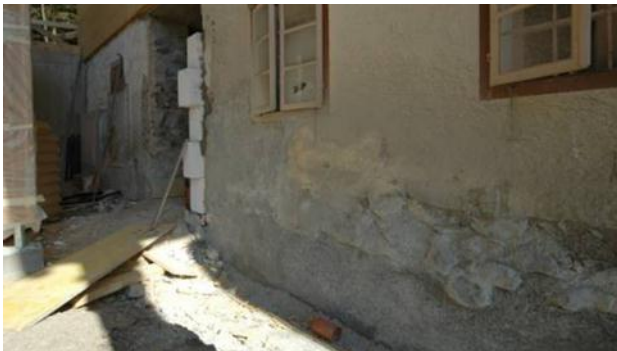
Abbildung 25: trockengelegte Außenwand vor Herstellung der Außendämmung
