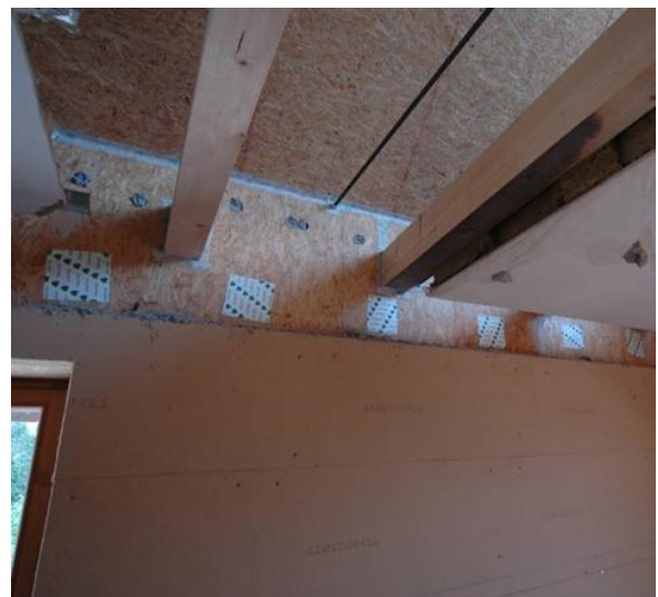
Abbildung 37: Herstellen der luftdichten Hülle im Bereich der Decke OG-DG durch verklebte OSB Platten.
