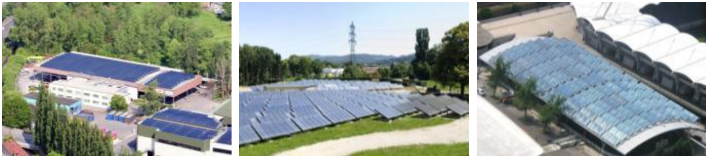
Abbildung 3-30. Thermische Solaranlagen gekoppelt an die städtische Fernwärme in Graz (von links: Fernheizwerk AEGV; Wasserwerk Andritz, UPC Arena) (Bildquelle: www.solid.at )
