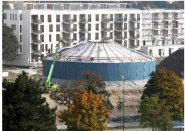
Solargestütztes 2-Leiter Nahwärmenetz mit Behälter-Wärmespeicher und Absorptionswärmepumpe
