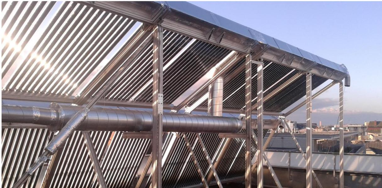
**Abbildung 7 Kollektorfeld am Dach der FH-Wels bestehend aus 196 Röhren (entspricht 32m<sup>2</sup> Kollektorfläche- brutto, bzw. ca. 16m<sup>2</sup> Absorberfläche-netto)**
