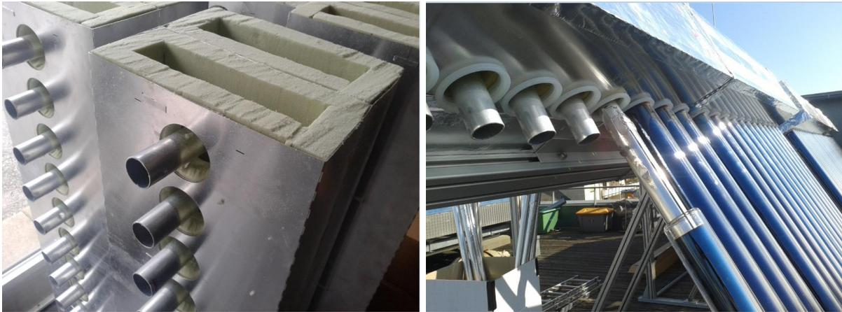
**Abbildung 6: Sammler (links) und Montage der Röhren mit innenliegendem Folien-Rohr (rechts)**
