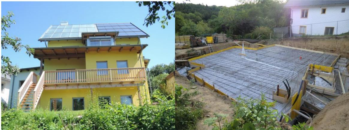
**Abbildung 47: Referenzgebäude (links) und Bodenplatte kurz nach Fertigstellung (rechts)**
