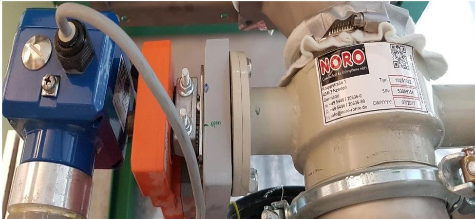
**Abbildung 12: Füllstandssensor, Hilfsschalter und Klappenantrieb der Trommel (von links nach rechts)**
