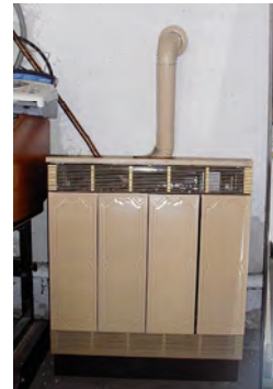
Gaskonvektor (Einzelraumheizung)
