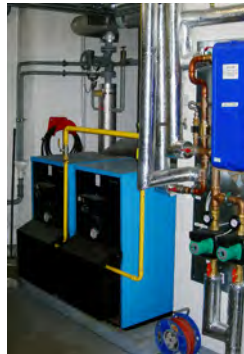
Gas-Hauszentralheizung im Keller eines Mehrfamilienhauses
