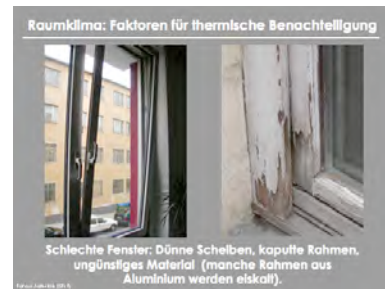
Folie 23. Schlechte Fenster: Dünne Scheiben, kaputte Rahmen, ungünstiges Material (manche Rahmen aus Aluminium werden eiskalt).
