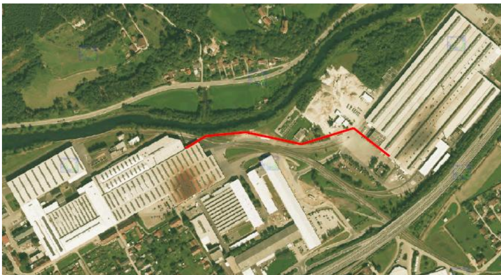
Abbildung 12: Zentrale Wärmeschiene zwischen Nahtlosrohrwalzwerk und Ölfeldrohrwerk
