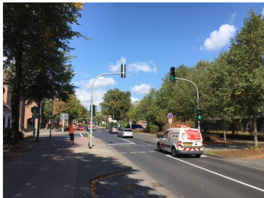
Abbildung 1: Testinstallation Raum Stuttgart
