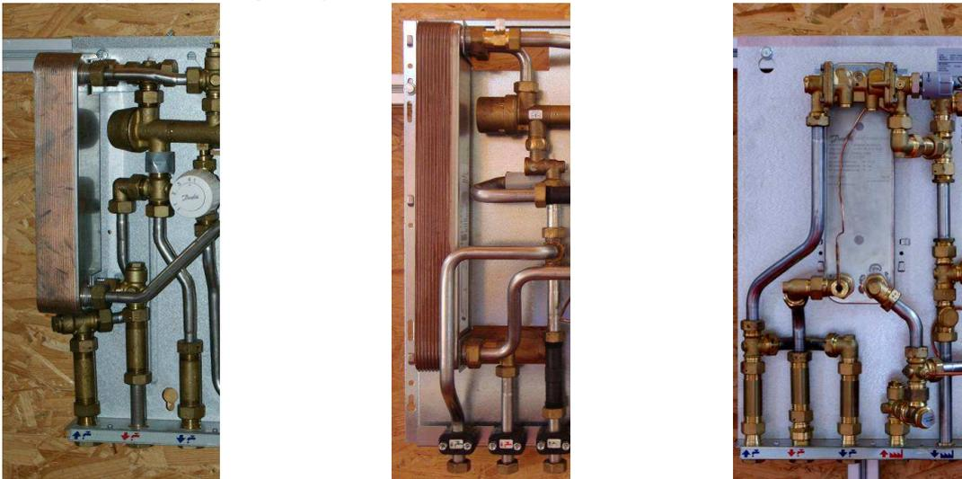
Abbildung 5: Ausführungsunterschiede bei Wärmetauschergeometrie und Anordnung (Leistungsgruppe 40 kW)
