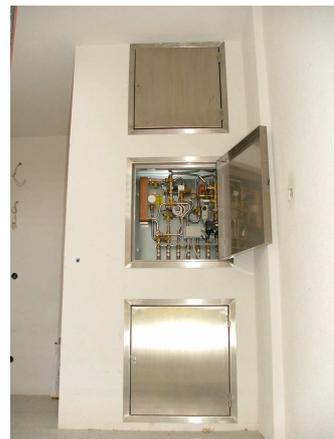
*Abbildung 15: Beispielhafte Anordnung von drei Unterputzstationen im Bereich des gemeinsamen Erschließungsbereichs. Vorteil dieser Anordnung: Die Zählerablesung kann sehr einfach ohne direkten Zutritt zu den einzelnen Wohnungen erfolgen.*
