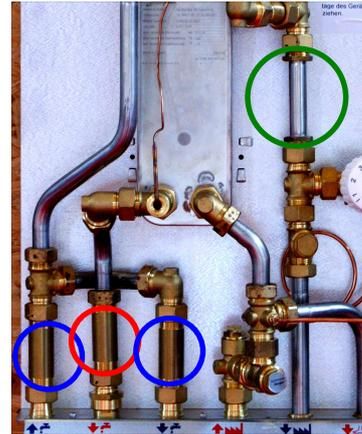
*Abbildung 13: Beispielhafte Hydraulikstation mit Passstückanordnungen, die jede Verrechnungsart zulassen würde (das Passstück für einen Wärmemengenzähler ist grün, das für einen Kaltwasserzähler blau und das für den Warmwasseranteil ist rot dargestellt).*
