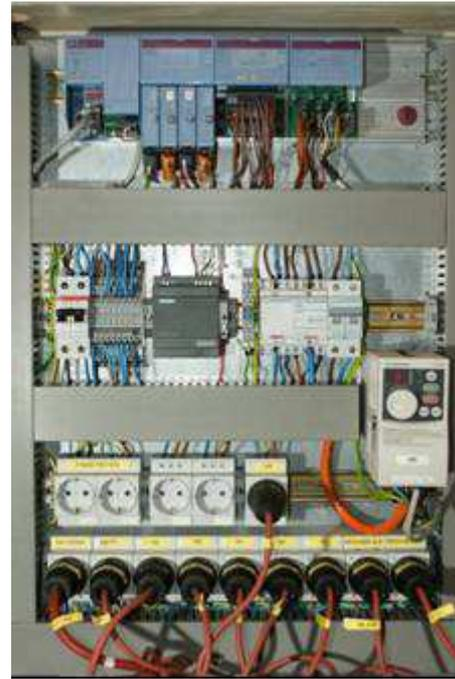
Abbildung 23: Schaltschrank freiprogrammierbare Regelung (SPS)
