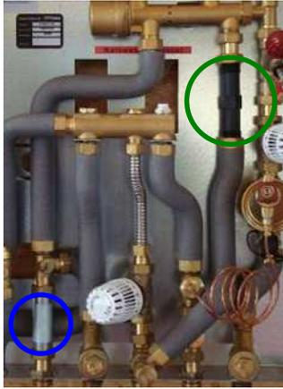
*Abbildung 12: Beispielhafte Hydraulikstation mit Passstücken nach dem Verrechnungsprinzip „Wärmemengenzähler (grün) und Kaltwasserzähler (blau)“*
