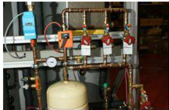
*Abbildung 21: Ansicht des Zapfmengenverteilers*
