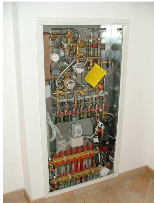
*Abbildung 3: Beispielhafte Hydraulikstation zur Versorgung von Niedertemperaturheizkreisen*
