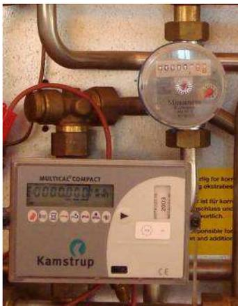
*Abbildung 14: Bestückter Zustand einer Hydraulikstation nach Verrechnungsprinzip „Wärmemengenzähler und Kaltwasserzähler“*
