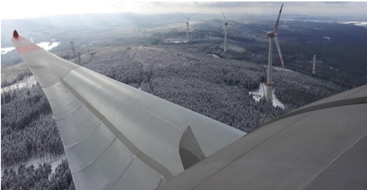
Abbildung 3: Blick Richtung Westen von der WEA die im Zuge des Projektes mit Messgeräten und Sensoren ausgerüstet wurde (Foto: VERBUND).
