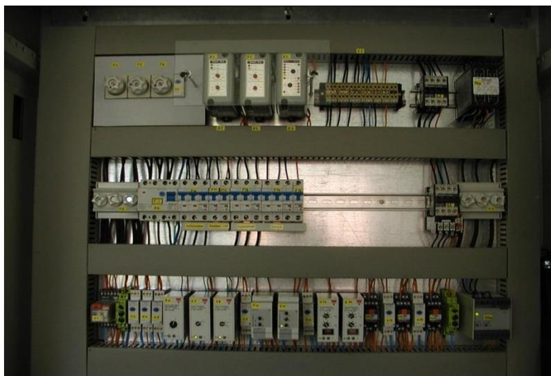
Abbildung 3-2: Beispiel für eine Relaissteuerung.
