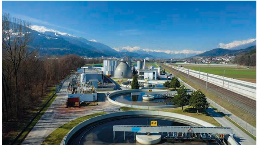
Abb. 27: Kläranlage Fritzens Tirol AWW Hall in Tirol - Fritzens.
