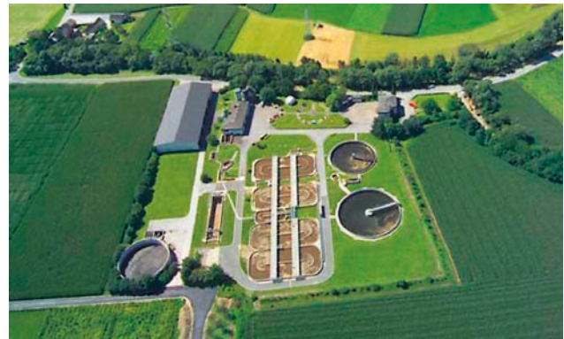
Abb. 26: Kläranlage in Gleisdorf. AWW Gleisdorfer Becken.
