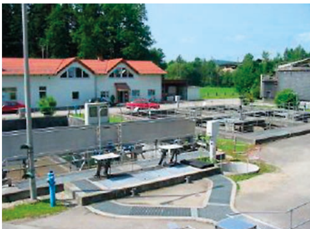
Abb. 25: Kläranlage Freistadt. RHV Freistadt und Umgebung.
