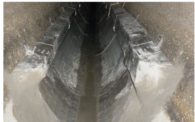
Abb. 20: Der Abwasserwärmetauscher „ThermLiner“ der Anlage STADTwerke Amstetten (hier kurz nach Montage im Abwasserkanal) wurde in Absprache mit der Stadtentwässerung geplant und gebaut und erlaubt weiterhin einen störungsfreien Betrieb der Kanalisation. STADTwerke Amstetten / Uhrig Kanaltechnik GmbH.
