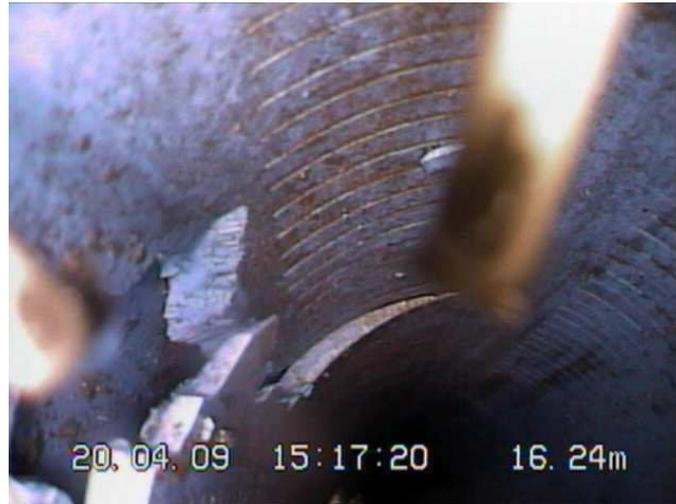
Abbildung 5: Beschädigung der Mantelfläche des Filterrohres in der Sonde Gamma
