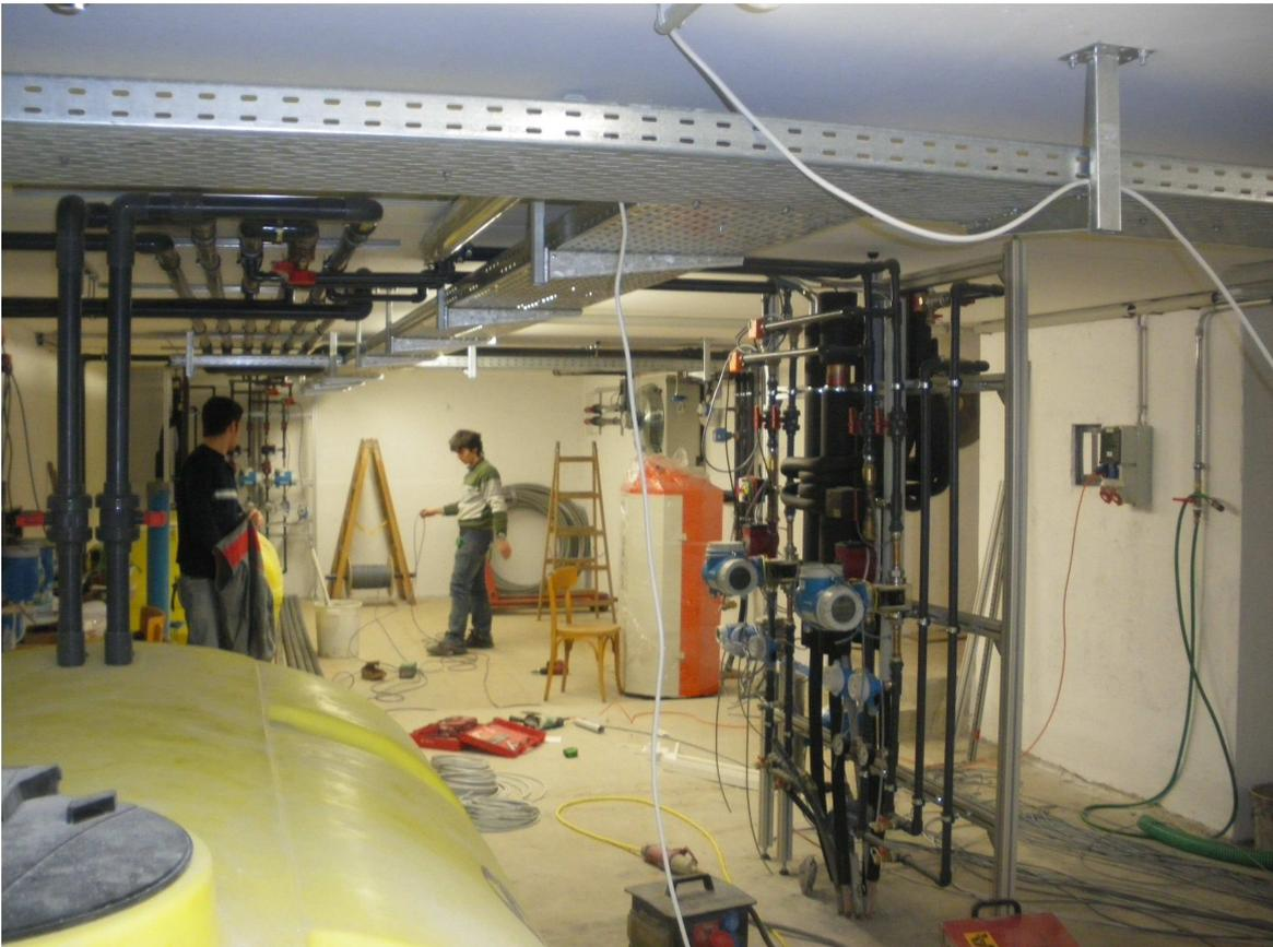
Abbildung 14: Montage und Installation der Sondenperipherie
