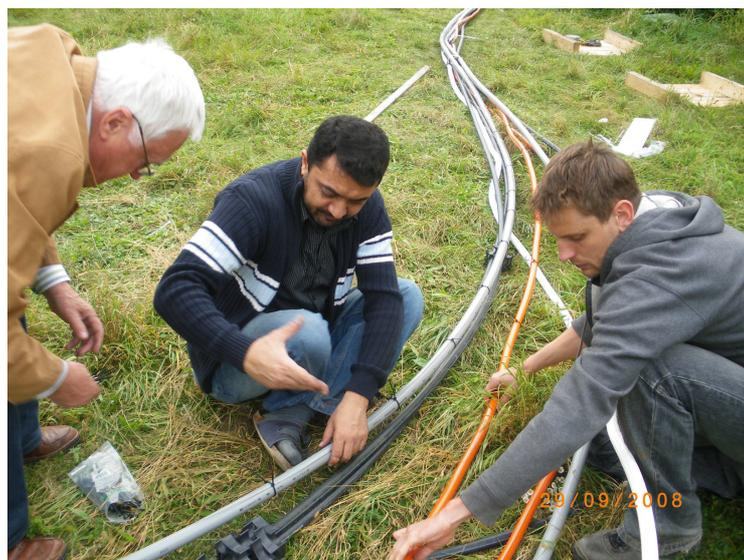
Abbildung 12: Ausrichtung der Rohrbündel mittels Abstandshalter
