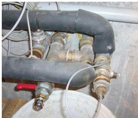
Abbildung 53: Sole - Sondenkopf mit Glasfasermesskabel
