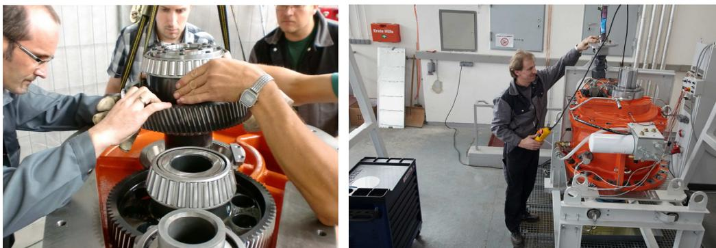
Abbildung 10: Montage Stirnradstufe/Schmierölpumpe
