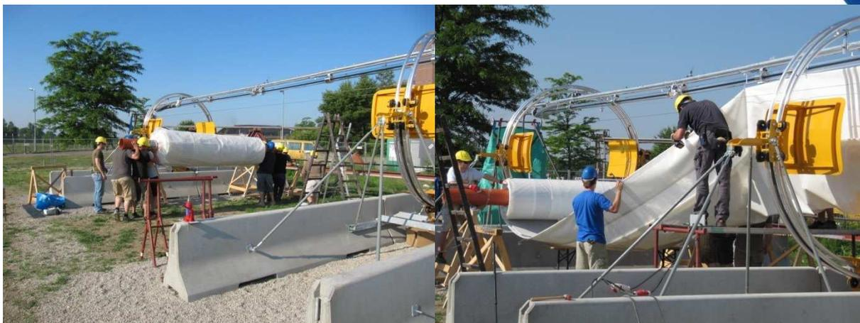
HELIOtube wird mit Einzugsystem montiert
