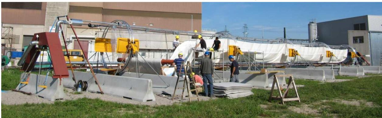
Installation der HELIOtubes durch Einziehen des Schlauches in die vorbereiteten Halterungen
