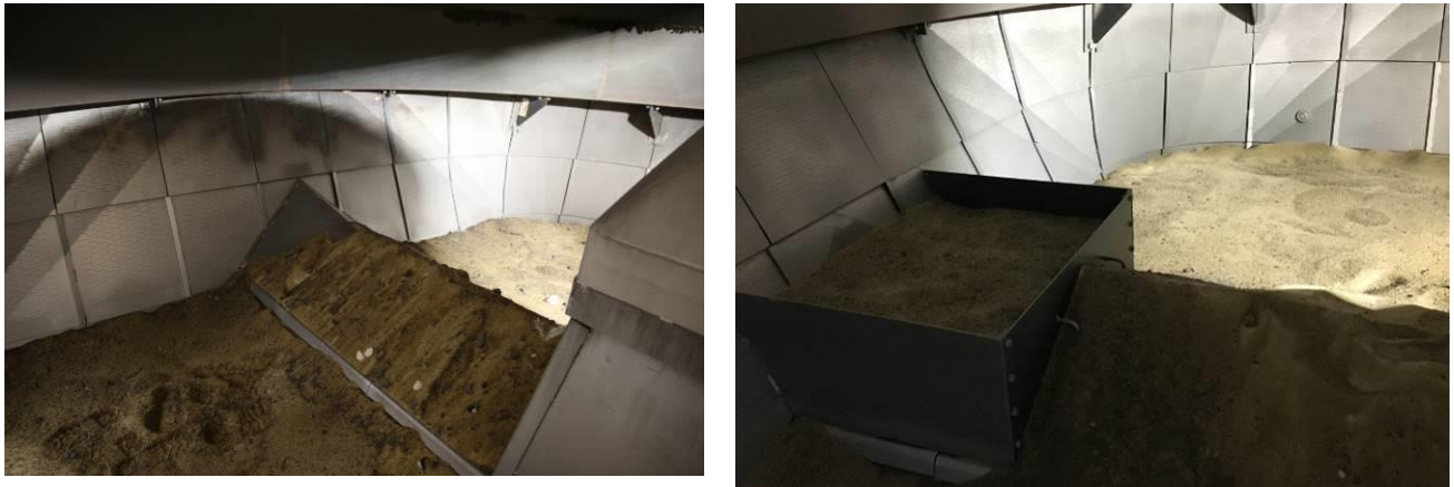
Abbildung 21: Links: Brücke im Granulator vor dem Umbau auf Wirbelschichtboxen. Rechts: Brücke im Granulator nach Umbau auf Wirbelschichtboxen.
