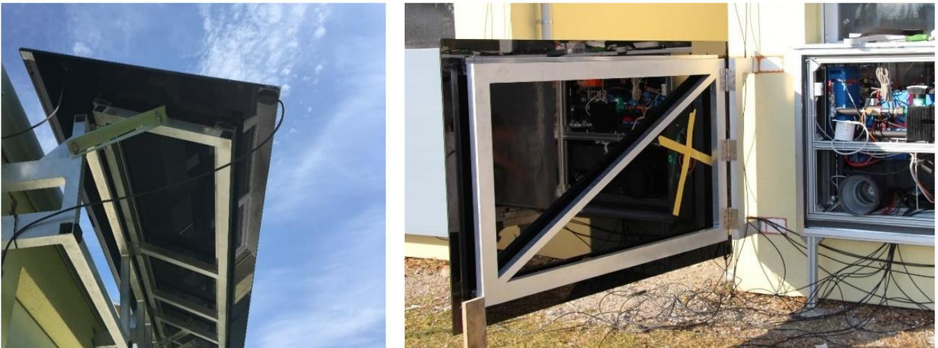
Abbildung 27: links ausgestellte obere PV-Paneele und rechts aufklappbare untere PV-Paneele
