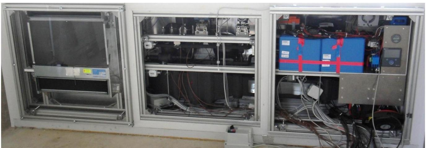
Abbildung 28: Konditionierungseinheit im Versuchsobjekt konditioniert von innen
