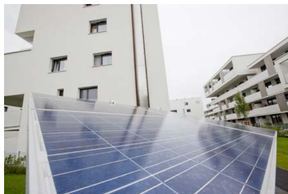
Abbildung 1: HiT Wohnanlage mit PV-Anlage und Pufferspeicher
