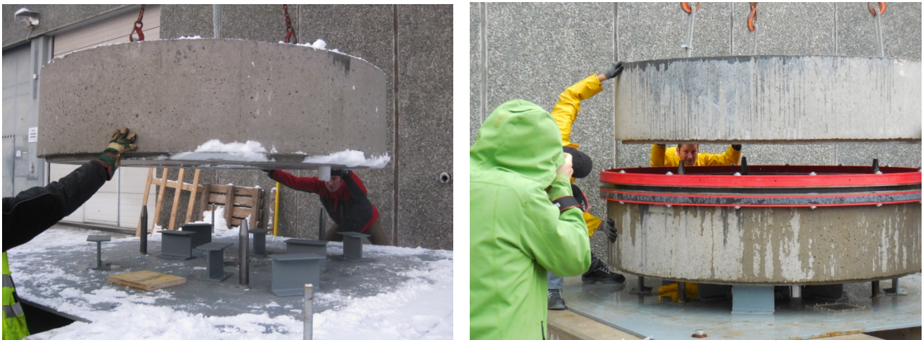
Abb. 5: Positionierung der Schwebbetonringe
