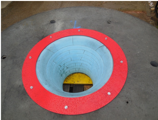
Abb. 8: Ein- bzw. Auslaufrichter
