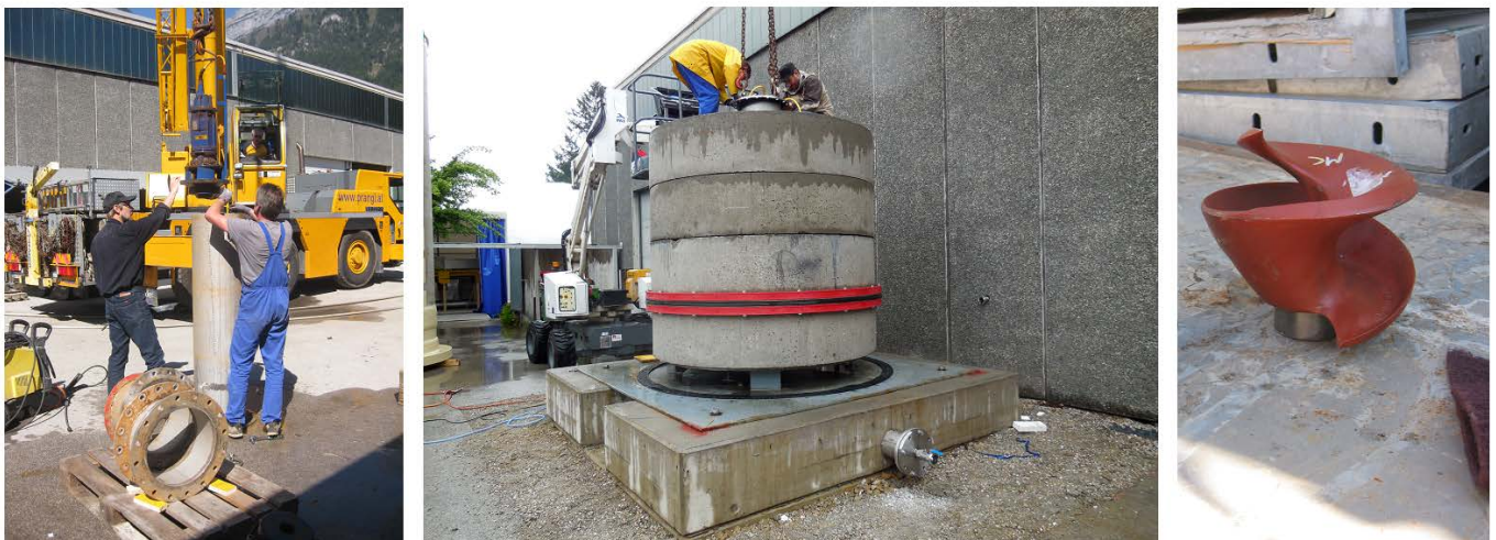
Abb. 7: Einbau der Pumpe
