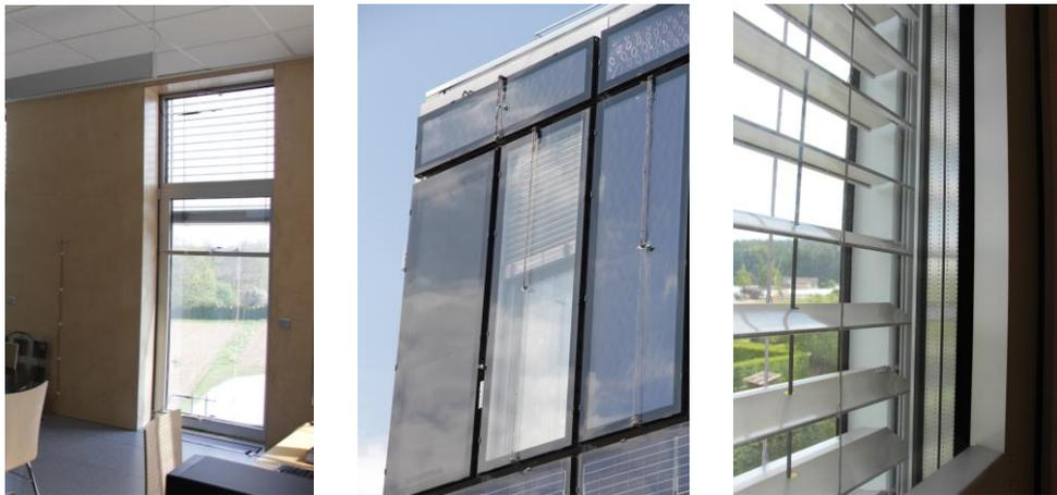
**Abbildung 64: Testfeld am Hans Höllwart – Forschungszentrum; Links: Innenansicht, Mitte: Außenansicht; Rechts: Detail Sonnenschutz**
