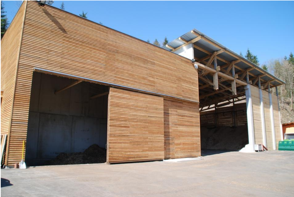
Bild 3 Biomasseheizwerk Wagrain (Quelle: nahwaerme.at)
