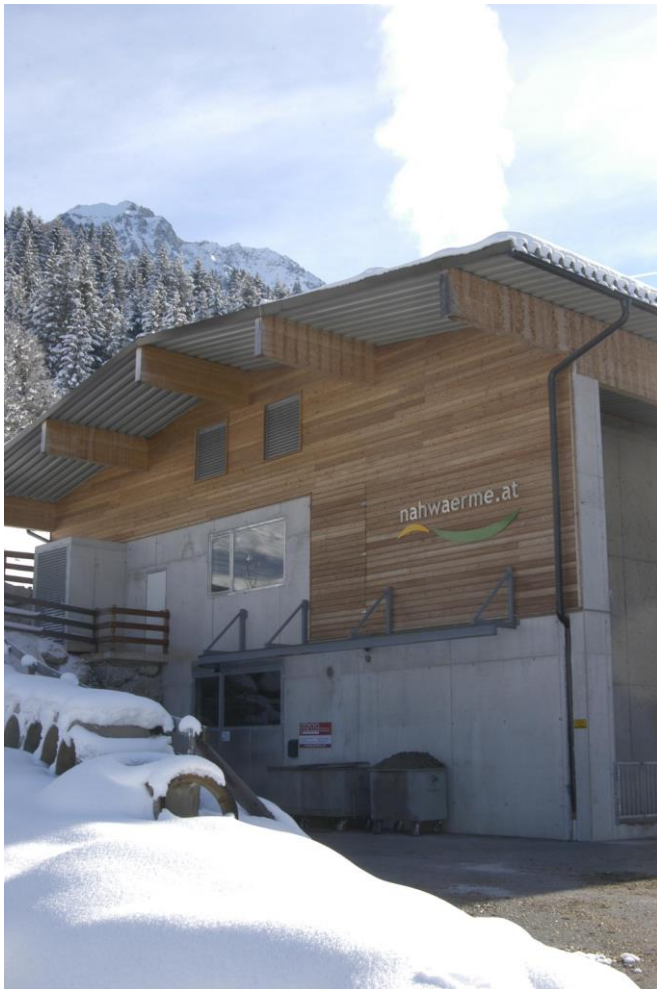
Bild 1 Heizwerk Kleinarl (Quelle: nahwaerme.at)
