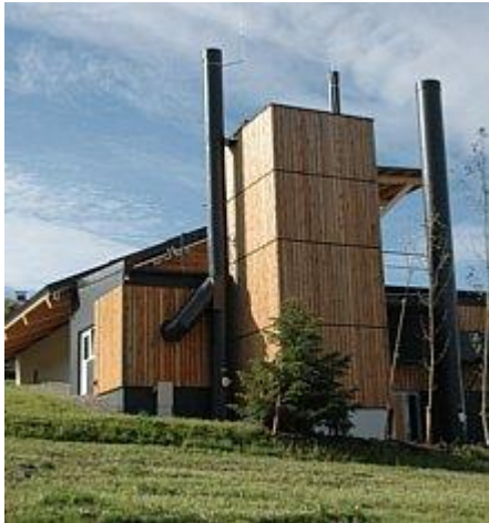
Bild 4 Heizwerk Mattsee (Quelle: nahwaerme.at)
