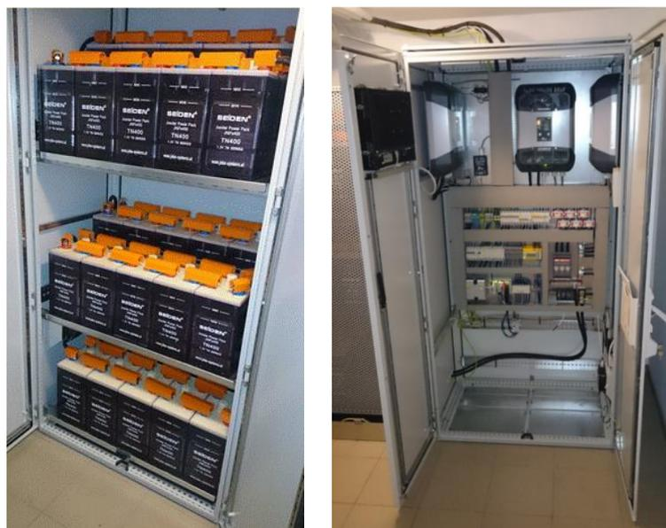
**Abbildung 6.20: Installiertes Speichersystem (NiFe Akku) in der Pilotanlage**
