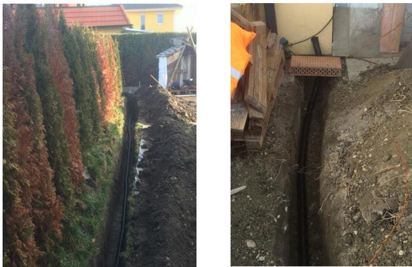
**Abbildung 6.40: Verlegung flexibles Kabelschutzrohr und Erdverlegung der Direktleitung in Haus B**
