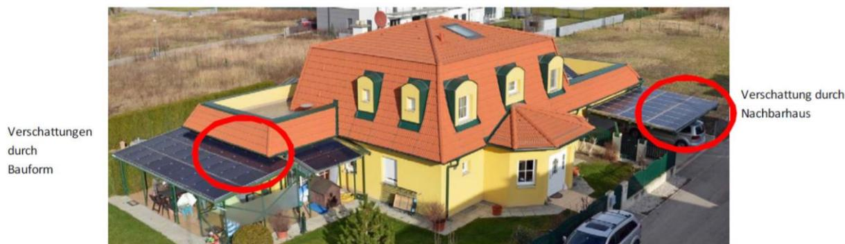
**Abbildung 6.18: Verschattungs-Problematik bei der PV-Anlage auf Haus A (Aufnahme im Jänner 2015)**
